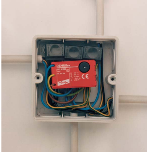
14. ábra: Alkalmazási példák 3. típusú túlfeszültség-korlátozók telepítésére a.) Túlfeszültség-védelmi eszköz telepítése falra szerelhető kötődobozba b.) Túlfeszültség-védelmi eszköz telepítése a csatlakozóaljzatba
