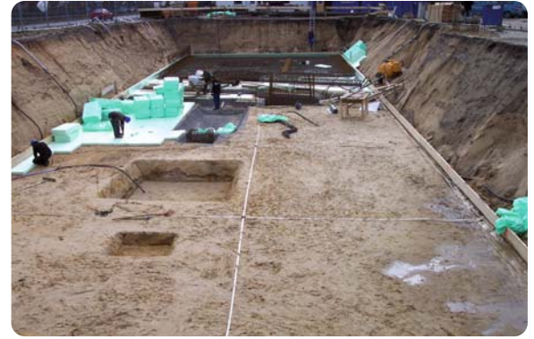
Ringerder bei Perimeterdämmung
