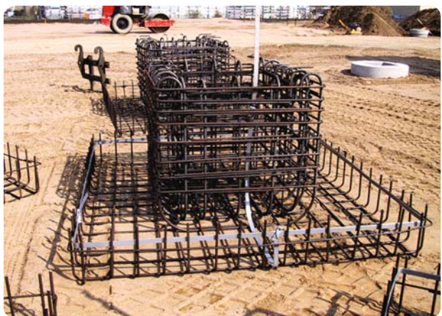
Fundamenterder bei Einzelfundamenten mit Anschlussfahne
