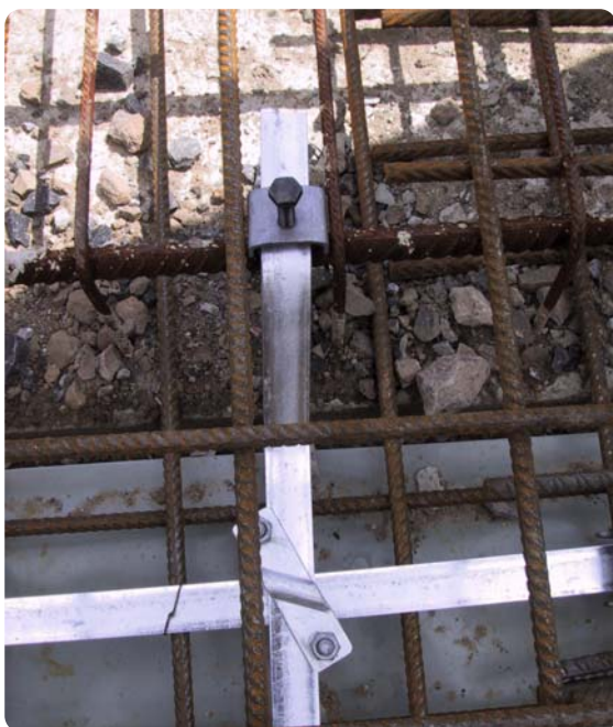
Anwendung Verbindungsklemme und SV-Klemme
