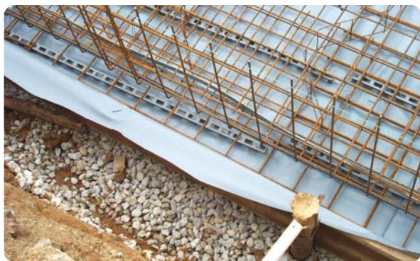
Folie bei Fundamentplatten
