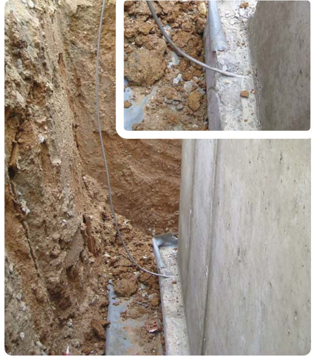
Korrosionsfreie Anschlussfahne aus NIRO (V4A)
