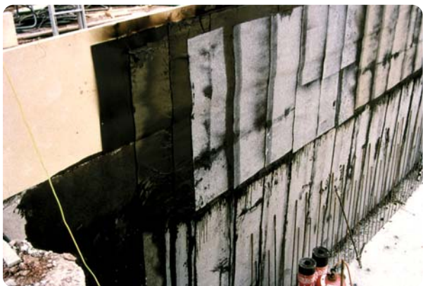
Bitumenbahnen als Abdichtung
