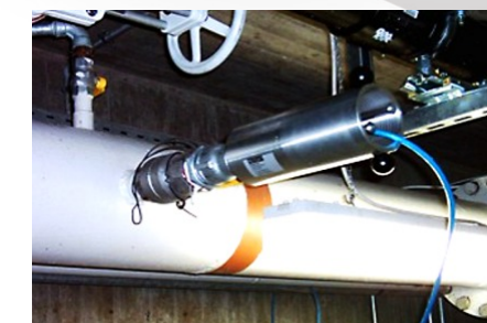
Un montaj retractabil adecvat permite curățarea cu ușurință a conductei de nămol fără nevoia de a îndepărta senzorul.
