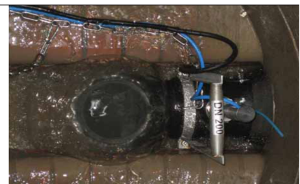
Mérőrendszer ideiglenes beépítése egy csatornába
