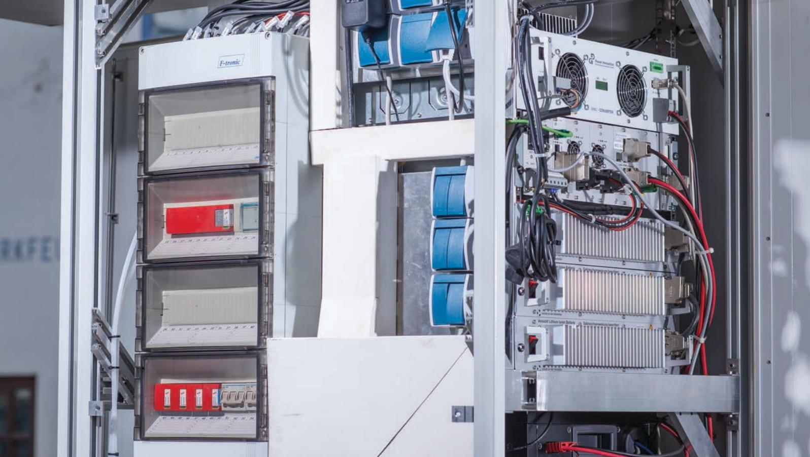
Die Solarzellen, die auf einen Schleuderbetonmast und Technikcontainer montiert sind, liefern zusätzlich 1,9 kW Leistung. Für den Fall einer Unterversorgung durch Wind und Sonne kommt eine Brennstoffzelle zum Einsatz. Die produzierte elektrische Energie wird in Lithium-Ionen-Batterien gespeichert und an die Verbraucher weitergeben.
