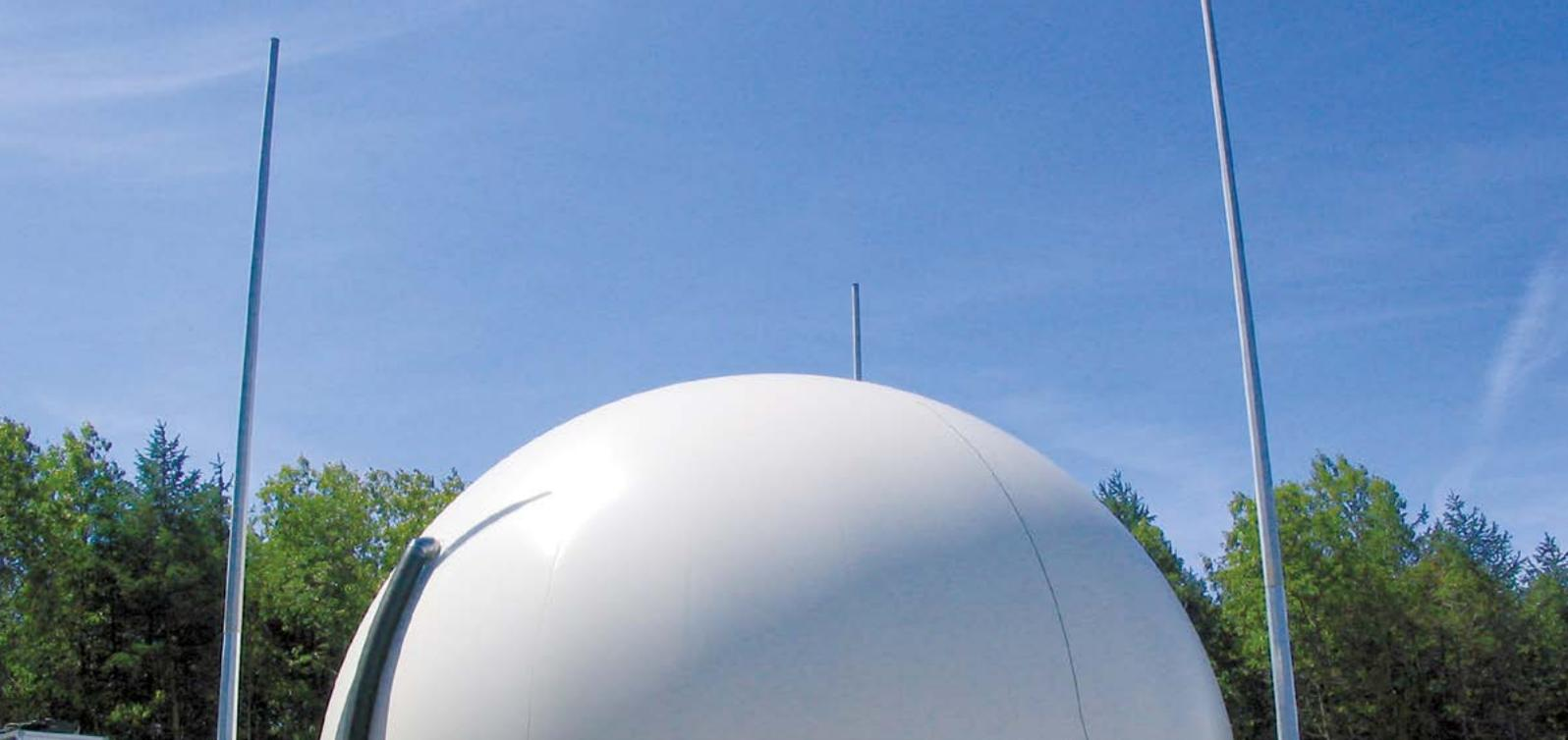
Gerade bei Fermentern mit großem Durchmesser hat sich der Einsatz von Tele-Blitzschutzmasten bewährt, um einen direkten Blitzschlag in den Fermenter zu vermeiden. Mit diesem System können große Teile in den einschlaggeschützten Bereich gebracht werden, ohne dass zusätzliche Seil-Überspannungen erforderlich sind.
