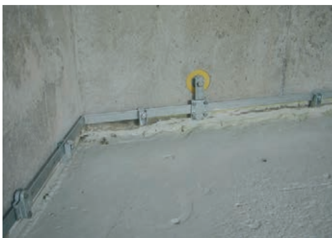
Ring equipotential bonding.
