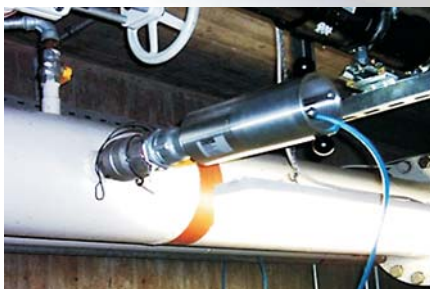
A megfelelő visszahúzó szerelvény lehetővé teszi az iszapvezeték egyszerű tisztítását az érzékelő kivétele nélkül.
