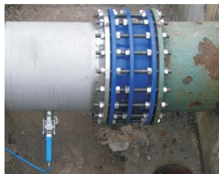
Egyszerű cső szenzor beépítés.
