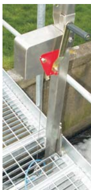
Kiemelőszerkezet ellenőrzési célból vagy az érzékelő kivételéhez üzemi körülmények között
