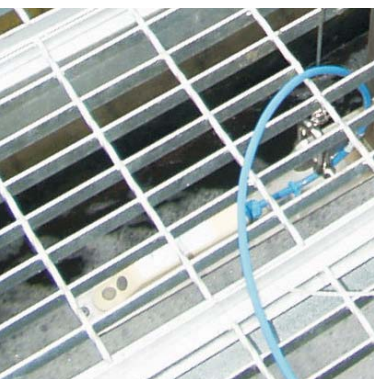
Kiemelőszerkezet ellenőrzési célból vagy az érzékelő kivételéhez üzemi körülmények között
