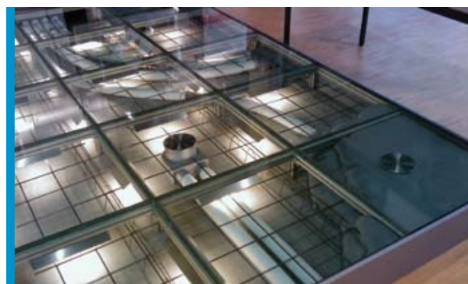
Szellőzővezeték padlóban, födémbe
