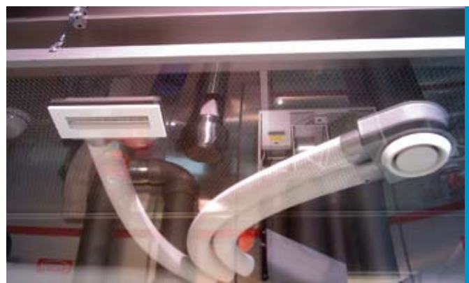
Szellőzővezeték az állmennyezetben
