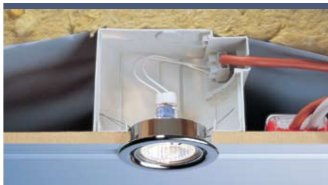
ThermoX – a ThermoX dobozok tökéletesen kontrollálják a lámpák hőjét – a megelőző tűzvédelem fontos elemeiként
