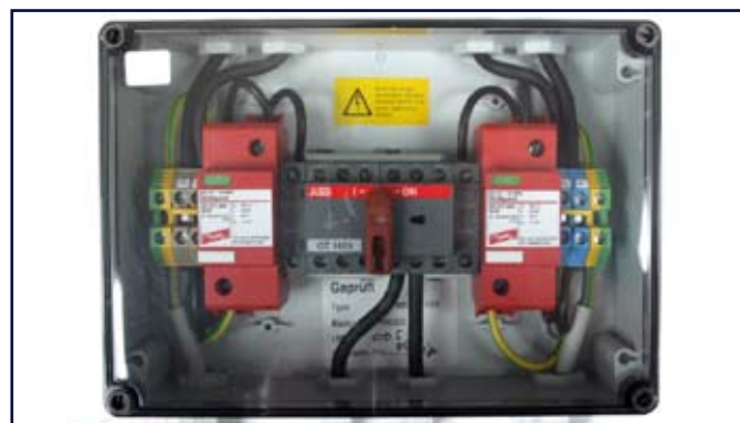
5. ábra: 1000 Vdc feszültségig használható fotovillamos túlfeszültség-védelmi modul
