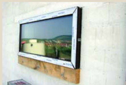
Hőszigetelés síkjába tolt ablakszerkezet
