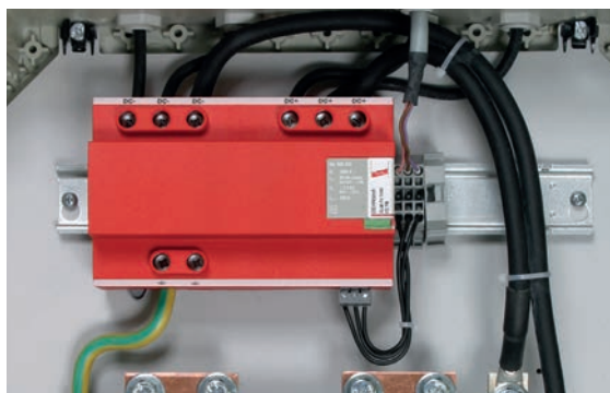
8. ábra DEHNlimit PV 1000 V2, 1. típusú, szikraköz alapú, kombinált villámáram-levezető
